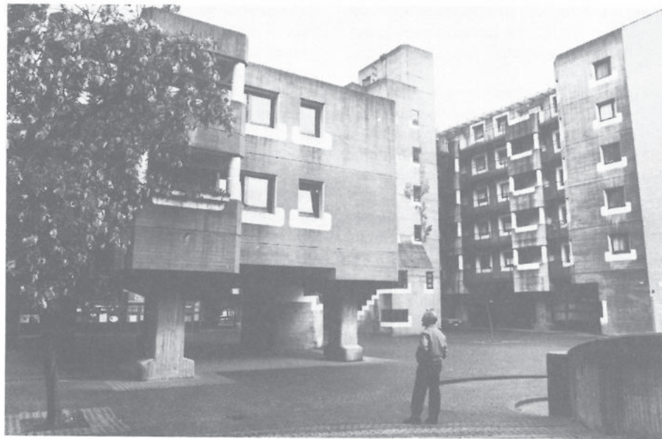
'BÖHM-Komplex' in Köln-Chorweiler
