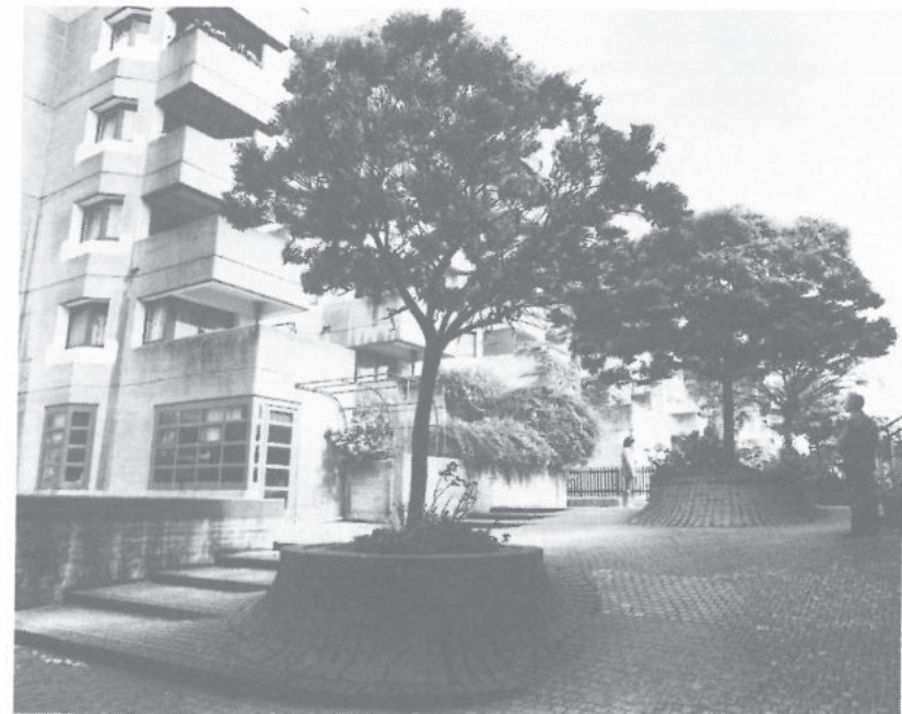
'BÖHM-Komplex' in Köln-Chorweiler
